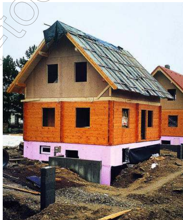
Fundamenty ocieplone twardymi płytami z polistyrenu ekstrudowanego
