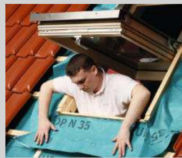
Kołnierz paroszczelny nakładany jest bezpośrednio na wełnę owczą oraz łaty
