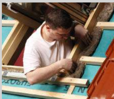
Bloczki z wełny owczej układane są pomiędzy łatami
