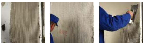
Na ocieplenie наносимы первую warstwę kleju (ok. 2 mm), następnie przykładamy siatkę i wtapiamy ją przez nałożenie kolejnej warstwy (1-2 mm) zaprawy
